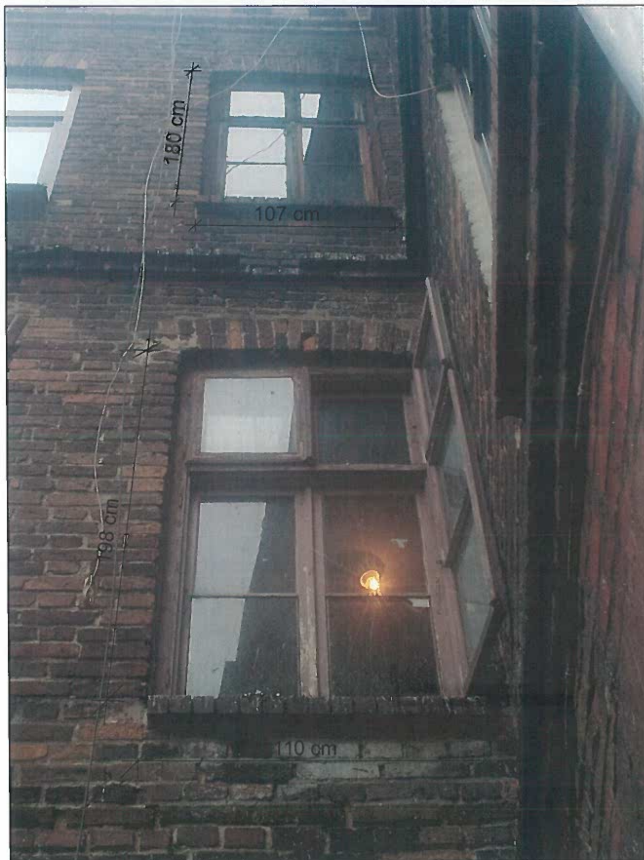
Klatka schodowa od strony ul. Limanowskiego. Okna usytuowane są od podwórza.
