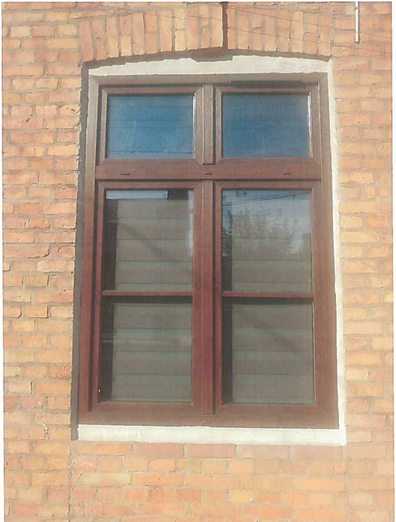
Poglądowy widok okna PCV zamontowanego w roku 2016
